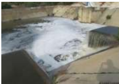
Figure 4: Bassin des eaux usées traitées
