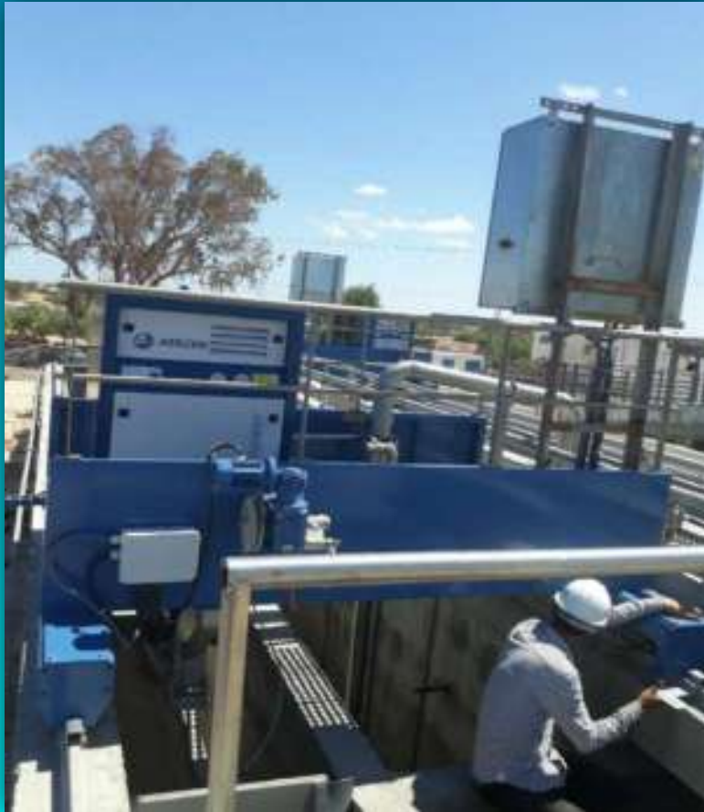
Renouvellement de l'unité de prétraitement (2 Dégrilleurs mécaniques + 2 désableurs-deshuileurs)
