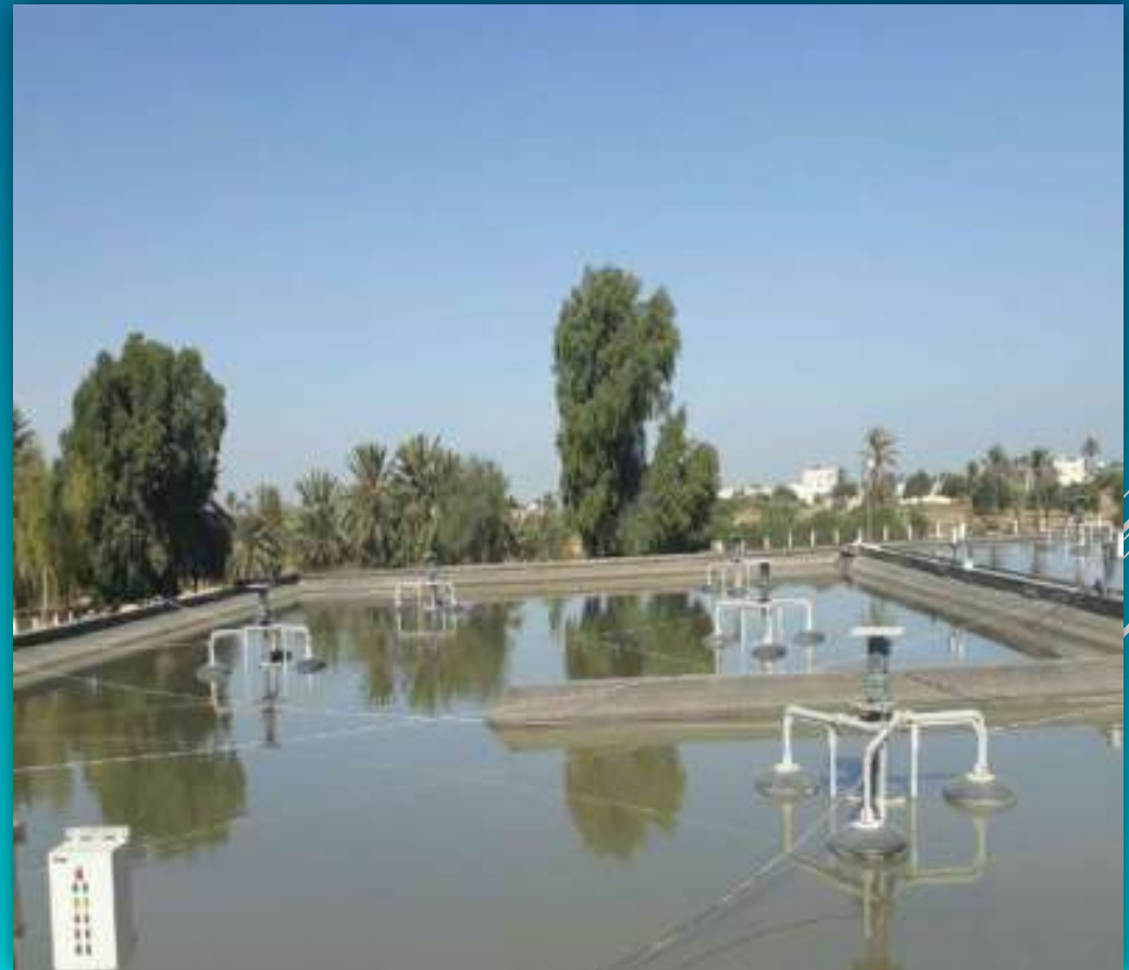
Installation de nouveaux aérateurs de surface
