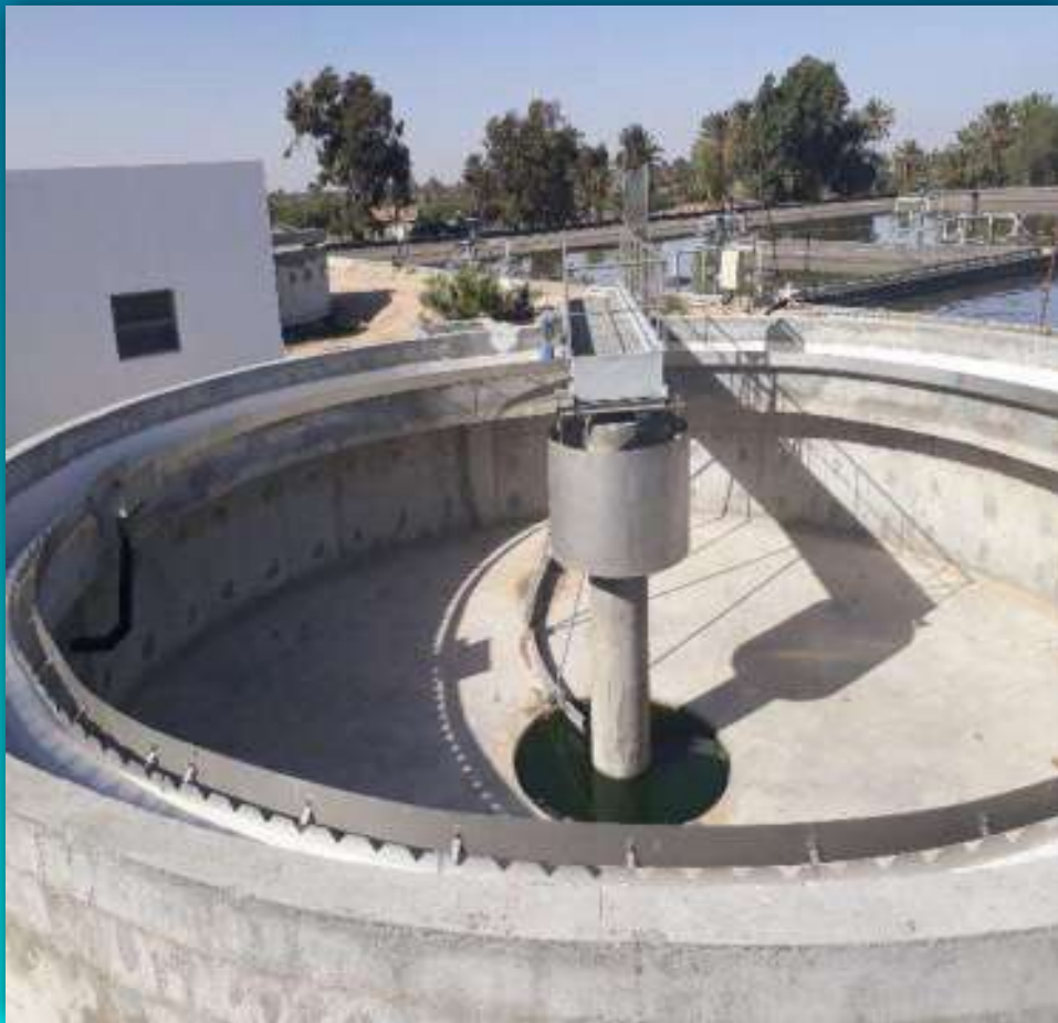
Travaux achevés au niveau des clarificateurs
