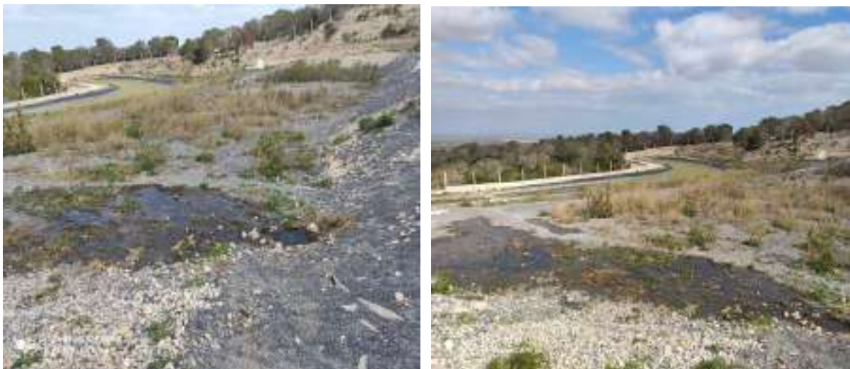
Figure 14. Surface de la tranchée d'alimentation du filtre planté 1 en charge
