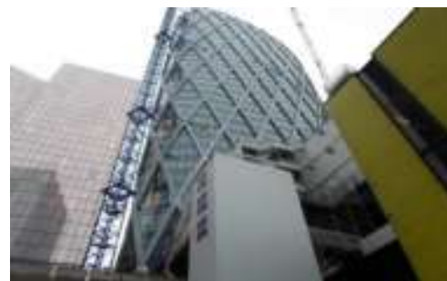
Chantier de la tour D2 Paris-France
