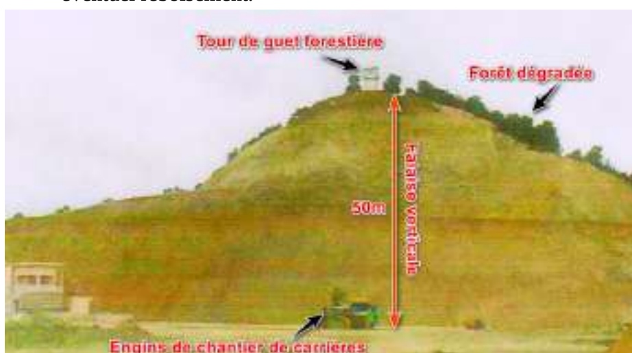
Photo 1 : Zone en cours de préparation pour la réhabilitation
