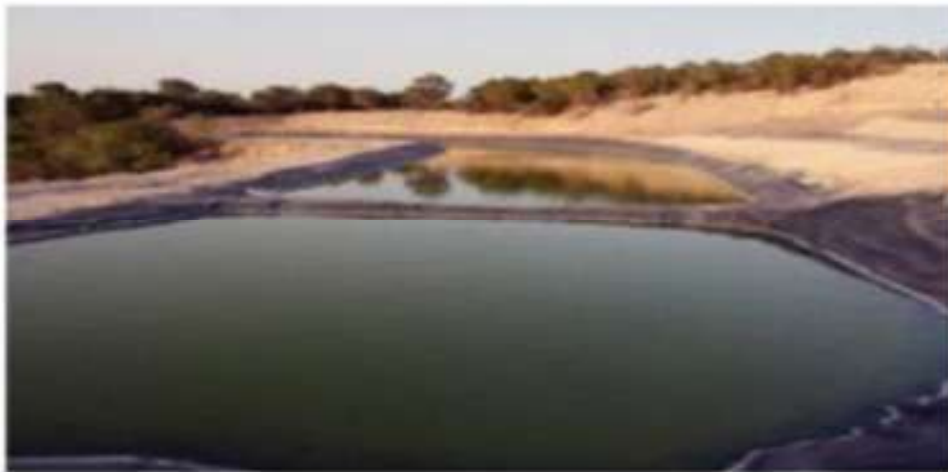
Bassin des eaux usées traitées
