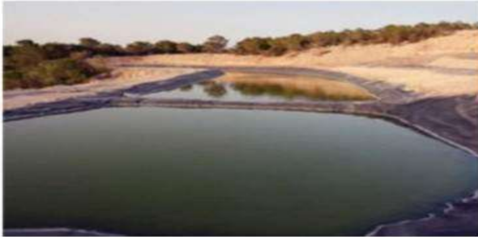
Bassin des eaux usées traitées
