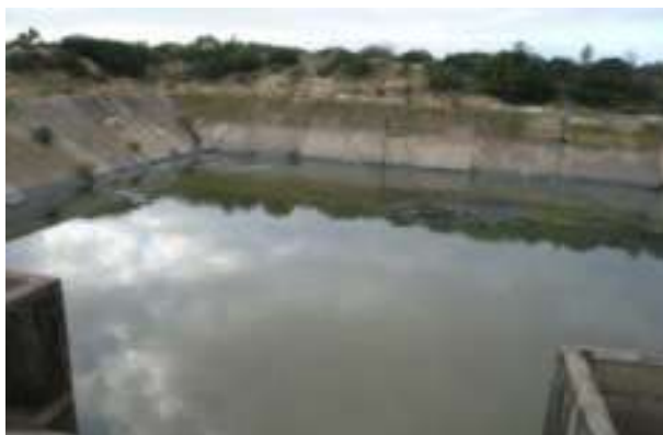
FIGURE 25 : BASSIN DE REGULATION EXISTANT
