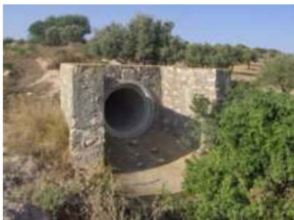
FIGURE 26 : CONDUITE DE SURVERSE EXISTANTE
